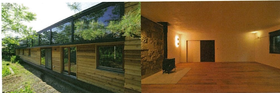
①南壁面の太陽集熱板でつくられた温水は 1000ℓのタンクに貯湯され、暖房・給湯・融雪に使用される。 ②既存使用品の薪ストーブの背面には「院内石」という地場の石材を張付け。蓄熱効果も見込まれる。
