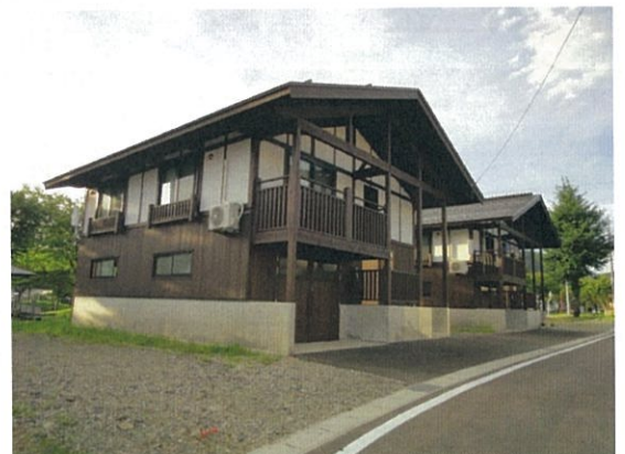
本町住宅完成風景
