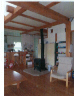
リビング暖炉 この暖炉一台で家全体をまるっと暖められるのは、高い断熱気密性能があるからです。
