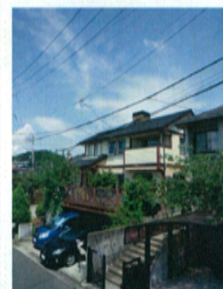
南側外観 屋根にソーラーパネル。窓はグリーンカーテンに覆われ、室内に差し込む夏の日射を防ぐ。デッキの下は車庫。
