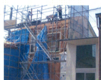
O邸工事中
