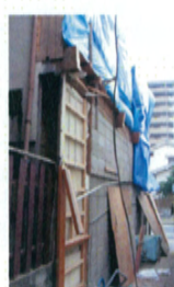
K邸工事中
