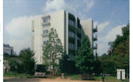
■防災広場側ファサード(アラカテ・トリス)
