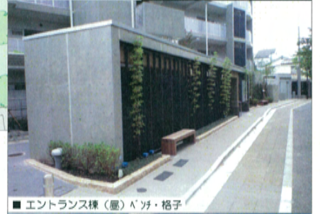
■エントランス棟(昼)ベンチ・格子
