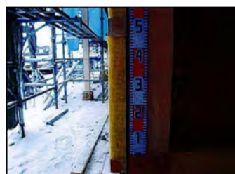
断熱工法。黄色の部分は付加断熱材 GW ボード 32 kg / m 3 60 mm。茶色の部分は土壁 (荒壁)
