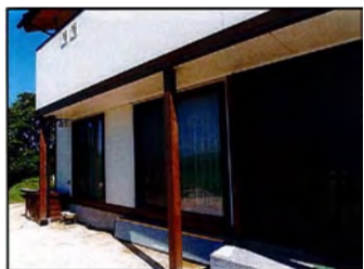
庇 (日射遮蔽)。南面掃出しサッシの 2F ベランダによる日陰の様子。ベランダの庇が効いている。8 月 18 日 AM 9 : 00 撮影
