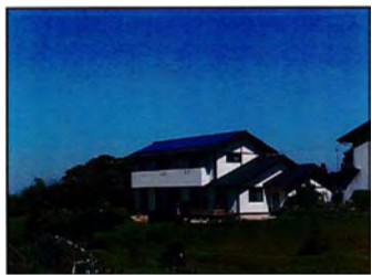
外観全景。真南を向けて建てている。周囲は田んぼに囲まれていて、風通りがとても良い敷地である。
