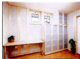
自然換気利用。2F ホールの窓は高窓。建物の中央付近にある階段を抜けてこの窓より温度差による自然換気を行う。
