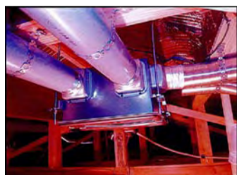
第一種換気システム。ロスナイセントラル換気システム。ダクトは全て 100 φ を使用。被断熱層の為、ダクト用断熱材を施工。
