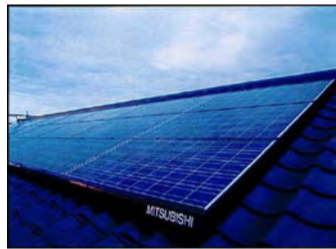
太陽光発電システム。能力：185W × 24 枚 = 4.44Kw。パワーコンディショナ交換効率 97.5%。2010 年 6 月現在
