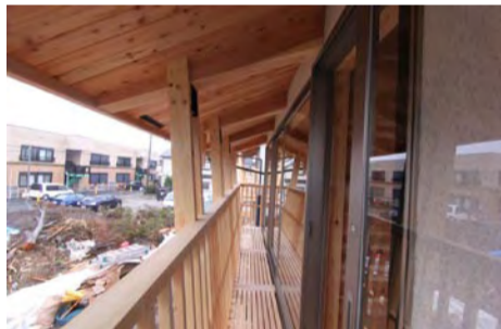
バルコニー。南面に吊られたバルコニー。一回の日射遮蔽の効果も兼ねる
