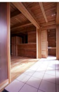
土間。タイル貼の蓄熱土間。天井はスノコ状で、上下の空気循環が生まれる。
