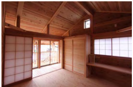
寝室。土間上部のサンルームと寝室は太鼓貼りで仕切ることが出来る。また、妻面上部に排熱用のルーバー窓を設置。
