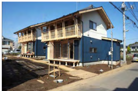
外観。同じ建物のように見える二棟並びの外観。屋根には、それぞれ太陽熱温水器とソーラーシステムが設置される。
