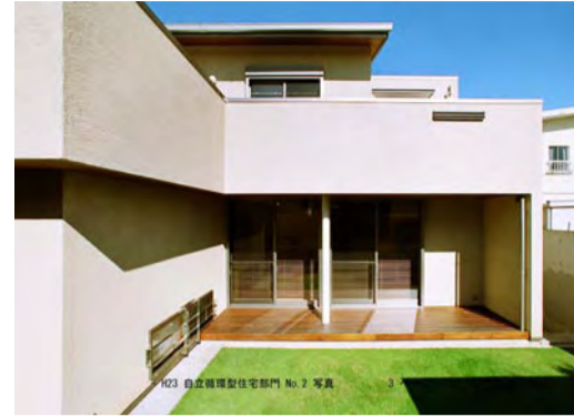
南側外観 深い庇は夏場の日差しはもちろん、雨降りでも窓が開けられる。
