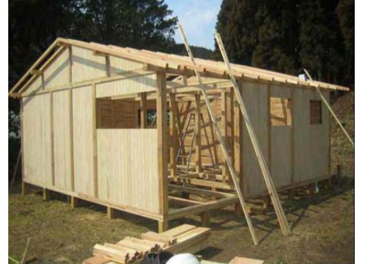
木造軸組み・落とし込み壁板工法
