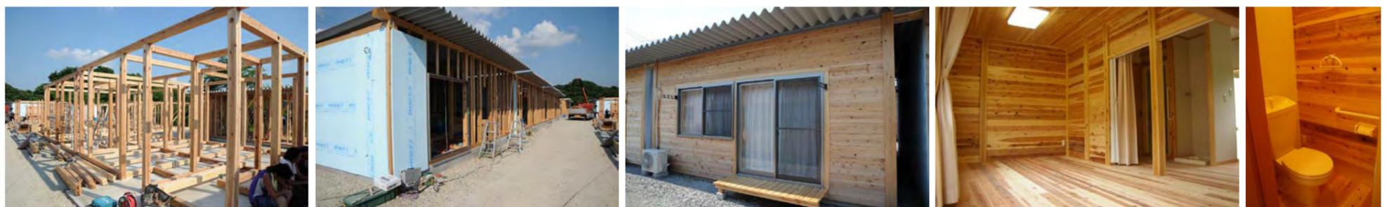
4寸材による木組み 外張り断熱外壁通気工法による高性能住 板張りの外壁と通風に配慮した大きな掃き 心とむ杉板張りの内装 トイレも美しい板張り
