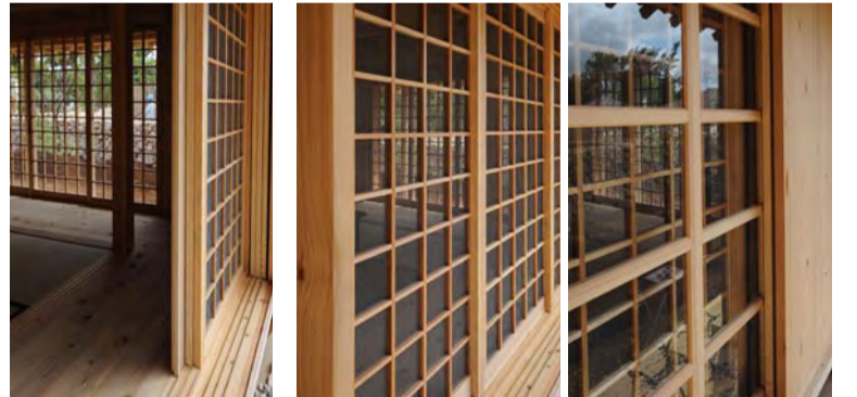
防犯を考慮した常時通風可能な大きな開口
