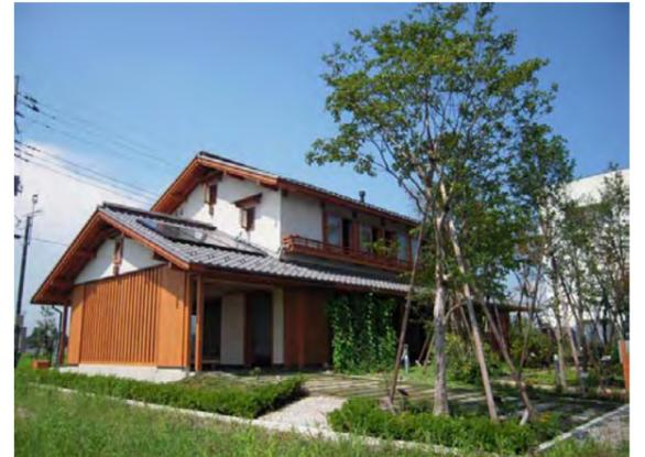
外観：南側雑木林の庭と建物外観 防風林として北側にはカシの木を植栽。1階屋根に太陽熱集熱温水パネル、2F屋根に太陽光発電パネルを設置。西側壁面は小さい窓やタテルーバーにより負荷を低減
