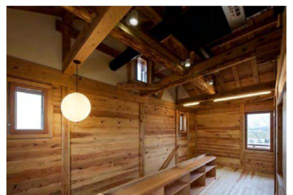
内観：2階階段ホール見る。杉板の落としこみ板壁(ささら板壁工法)を見る。
