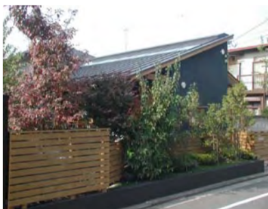
南東の前面道路から見る。高さを抑えた屋根と深く出た軒、OMソーラーの集熱がうかがえる
