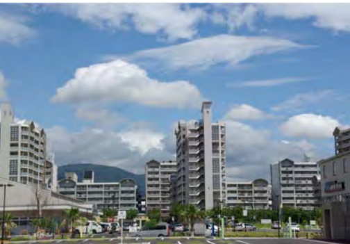
広く市民が訪れる商業施設をのぞく公営住宅
