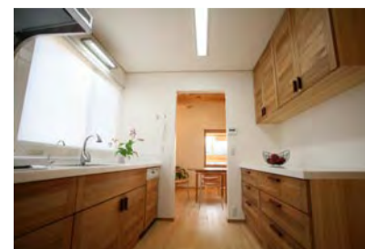
⑤手づくりキッチン。建具職人が手づくりしたキッチン。引き出しも無垢板でつくっており、把手は漆職人が拭き漆で仕上げている。
