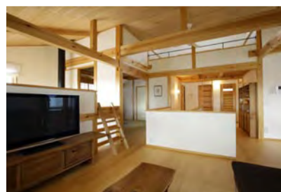
③内観 LDK-2。杉の木製建具と漆喰の塗壁に、畳は手縫いの藁床を使用。建具職人、左官職人、畳職人の技が光る。
