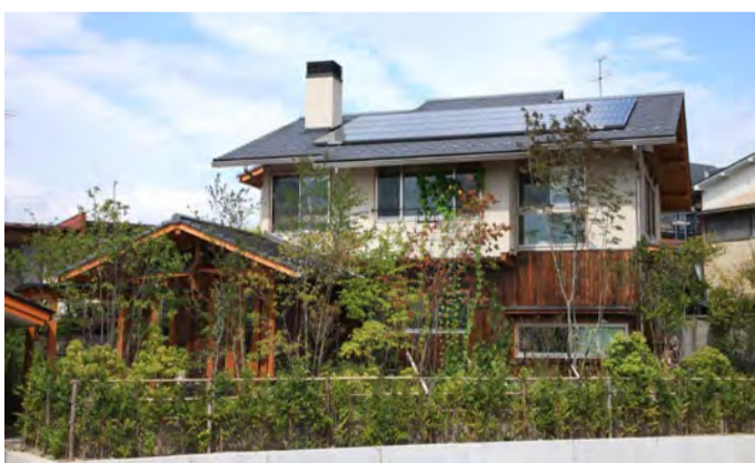
①外観。平瓦を使用した屋根に、焼杉板を張った外壁。庭には多様な植物を植え、季節の移ろいを楽しめる。
