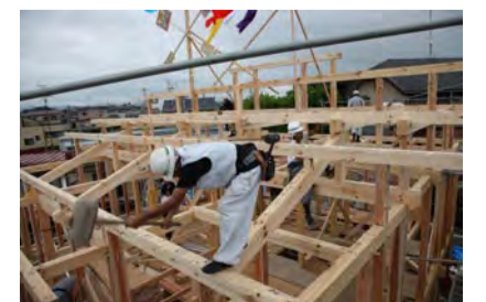
⑥伝統的な木組みの技術を活かした施工。大工職人が墨付け・手刻みした木材を極力金物に頼らずに施工。伝統的な木組みの施工は弟子職人の技の向上にもつながる。
