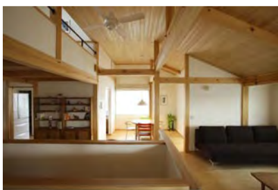
②内観 LDK-1。架構を守った設計と大工職人の手刻みによる施工で、構造美が特徴の2階リビング。
