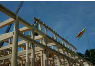
⑦建方。昔ながらの御幣を立てて、掛け声を交わしながら積み重ねていく。屋根面の剛性を軸組みに伝えるための駒材が母屋にとりつけられている。
