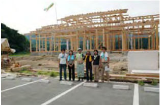
⑧事務所のスタッフも建方を経験。棟が上がったところで建主と一緒に記念撮影。
