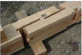
⑤設計図に沿って墨付けが行われ1本ずつ丁寧に仕口加工が施される。これはよく力を伝える金輪継ぎ。
