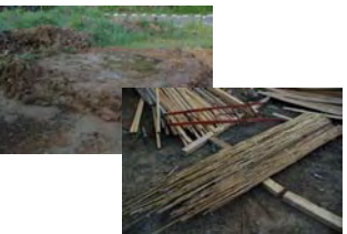
⑥山から土を取ってきて、水を加え敷地の隅でねかせる。小舞竹も山の竹を裂いて作る。
