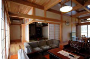
⑩大分の名のある宮大工が建てたという旧宅から松の床をはずし、化粧廻りをつけて和室の半縁天井を組む。書院の格子も洗いをかけて再利用。京間の旧宅に合わせてメーターモジュールを採用したので、ほぼそのまま再利用出来た。
