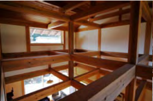
⑪・⑫何層にも積み上がる小屋組みは日本建築の美を引き継いでいる。
