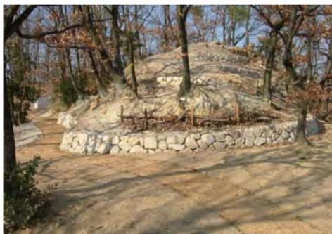
土砂流出防止の石垣としがら：山の崩壊地は、空石積やしがらなどの多孔質土止めを設置し表土の流出を抑えると共に生物生息環境の向上をはかった。
