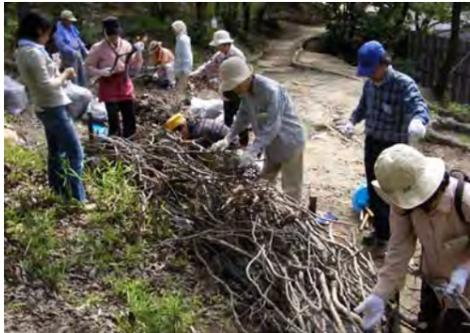
林床の落ち葉ダムづくり：落ち葉や表土の流出を防ぐため、現地の枯れ枝などを集めて杭で止めた落ち葉ダムを設置した。
