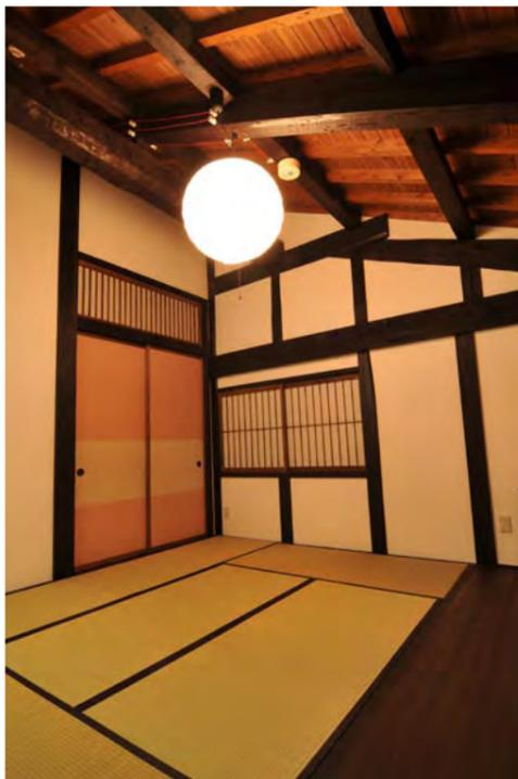
写真⑦：客室。3mの豪雪にも耐える太い梁とインテリアに配慮されたがいし引き電気配線。
