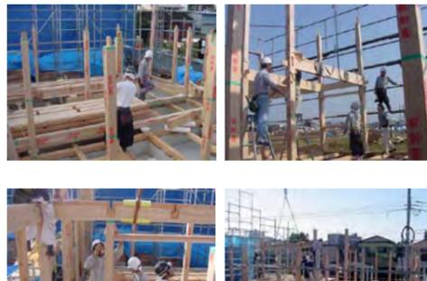
▲ 木材は、遠野の住宅建設協会の作業場で、手刻み(ルーターやホゾ取機)によって行われる。木材の使用量は、1.2㎡/坪で40坪の住宅で約50㎡となる。構造材・羽柄材・板材・壁・天井は10t車3台で順序よく東村山に運ばれ、地場工務店の大工により組み立てられる。1期では、遠野の刻んだ大工が建て方まで指導として付き合ったが、2期以降は地場大工のみでスムーズに進行した。特に建て方の期間中は、地域の工務店の見学が殺到し、人だかりができるほどであった。
