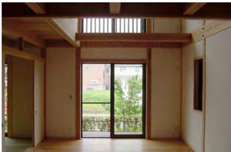
▲ 居間の上部が吹抜となっているタイプ。内部は珪藻土塗りの真壁で、通し柱・5寸角・梁・4寸×8寸。和室の換気はガラス欄干で内部空間の連続感。吹抜部の窓を開閉する椅子状キャットウォーク。
