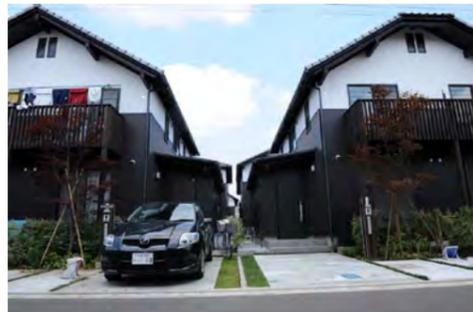
▲ 北宅地の通風・日照に配慮し向かい合わせに配置した下屋。隣棟間に距離を生ませ自身も明るい。外壁下部はガルバリウム鋼板、上部は漆喰塗り。準防火であるが軒は厚板を扱い準耐火を満足。
