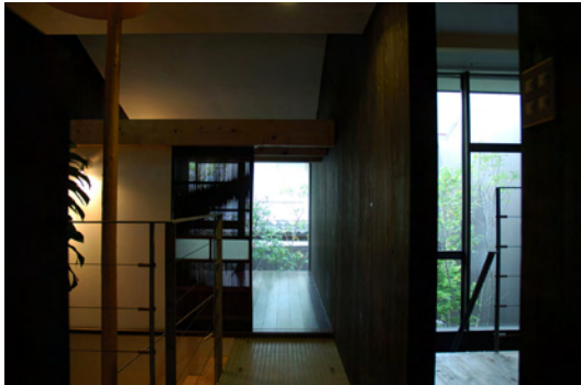
▲厨房より室3を見る：漆塗りの床（室3）に庭の緑が反射する。室3を仕切る建具は中古建具で格子の部分には障子がけんどんではめられる。
