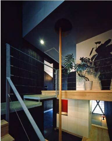
▲吹抜け廻り：長さ7mほどの北山杉が小屋裏収納まで伸びている。その廻りの壁と天井は黒谷和紙、玄関脇に見えるのが赤い漆塗のパネル、横架材や床板などには全て京都産の杉と桧が使われている。
