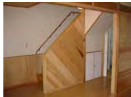
スギ板仕上のタウンハウスの内部階段
