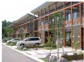
スギ集成材フレームによるタウンハウス南側外観 PC板を再利用している駐車スペース
