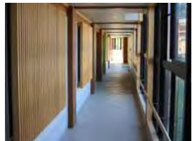
木3共の屋内廊下と面格子
