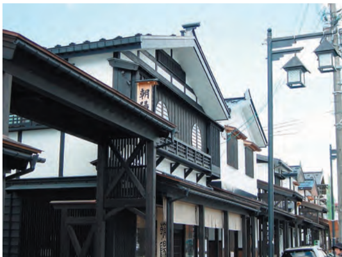
雁木と調和する家並み / 地域独特の意匠である「風返し」を取り入れ、色彩にも配慮した建物が軒を連ねています。
