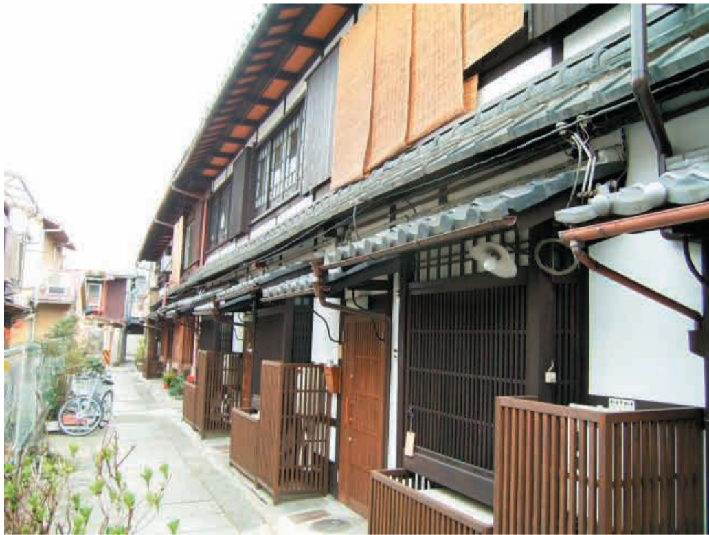
前面路地と再生長屋外観（防火性を向上しながら、伝統的なファサードを再生）
