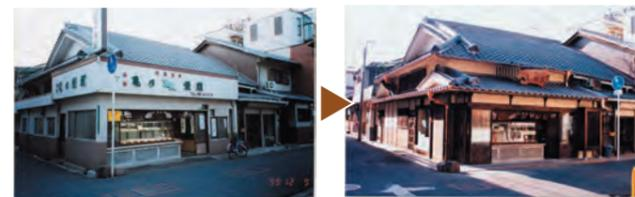
**店舗（花ちとせ）：**高2階建て町家の修景。1階軒庇を復活。シャッターを撤去後、木製建具を設置した。1階壁を板張りとし、漆喰調塗装、2階をタイル張りとした。
