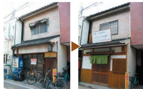
**店舗（喫茶富永 / Ken's Bar）：**平屋建て町家の修景。既存壁面モルタル増築部分を撤去、木製出格子とした。既存出格子部分、腰板の張替え、漆喰部分の塗り替えを行った。既存屋根トタン部はトタンを新調、瓦部分は本葺きで葺き替えた。
