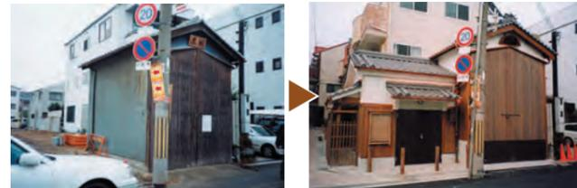
**住宅：**つし2階町家の外観の修景。外壁を漆喰塗り腰板張りとし、玄関建具、シャッターを木製格子戸へと修景。郵便受けを埋込型にし、設備メーターを木格子で囲うなど目立たないよう配慮されている。
