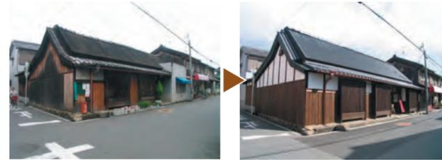
**住宅：**1階壁面既存モルタル壁部分を焼板漆喰塗りに変更、シャッターを撤去後、木製建具を新設。既存木製格子を補修。2階壁面漆喰塗り。屋根をいぶし瓦葺とし、銅製の雨樋を設置。
