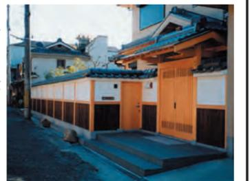
**塀・門及び車庫：**既存駐車場の塀及び車庫の修景。瓦葺、漆喰塗、腰板張りなどを採用したデザインで、並びにある蔵の外観に合わせて修景を行った。
