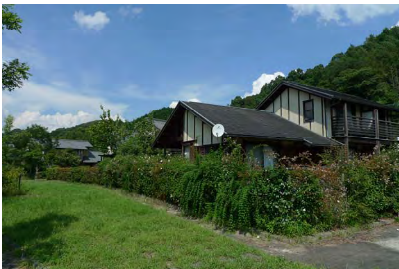
木造2戸1の山田市営尾浦住宅
