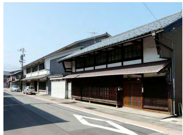
市営住宅「大野市西二番町屋住宅」10 戸 (奥の建物)
