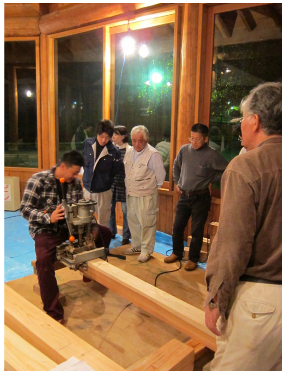
山形県金山町で実施された大工育成塾
